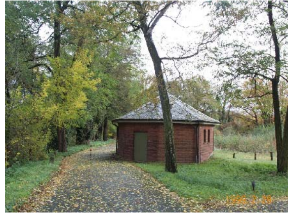
Bild 1.1 Ein fernüberwachter Hochbehälter.
